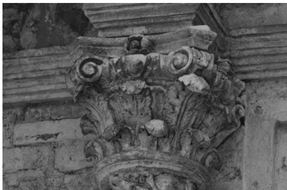
Капитель колонны крыльца Введенского собора. Сольвычегодск. Фотография Д. Д. Линникова, 2016 г.
