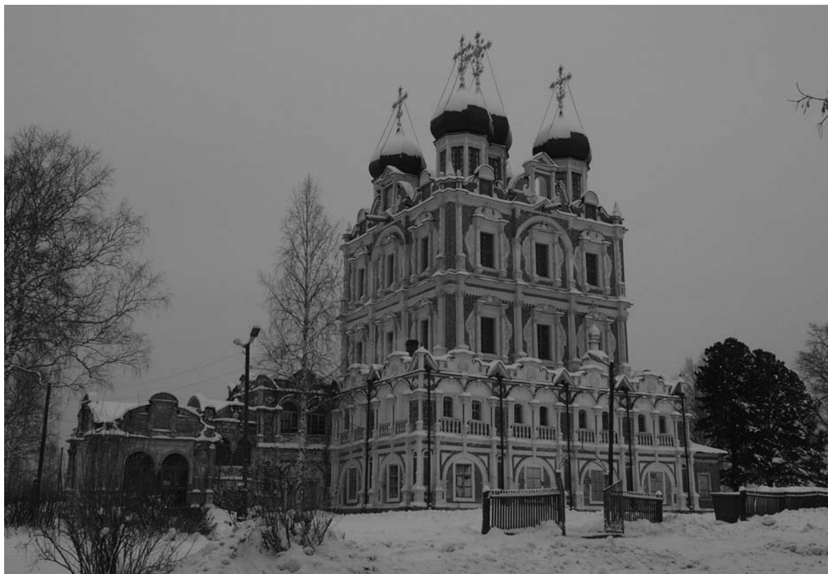
Введенский собор с юго-западной стороны. Сольвычегодск. Фотография Д. Д. Линникова, 2016 г.
