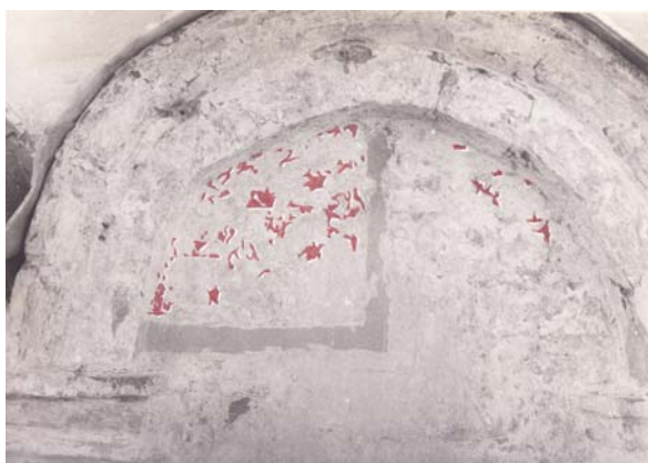
Архангельский собор. Центральный барабан. Северная сторона. Плоскость стены под аркатурным поясом. Остатки красного красочного слоя, лежащие на известковой смазке. Зондаж № 5 (3). Фотография с расцветкой гуашью В. Робинова, 1967 г.
